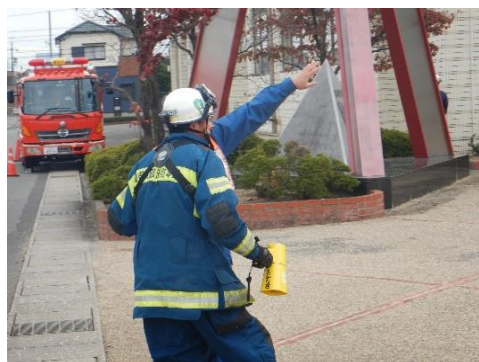
漏洩場所の確認
