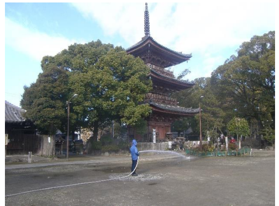
屋外消火栓を用いた放水
